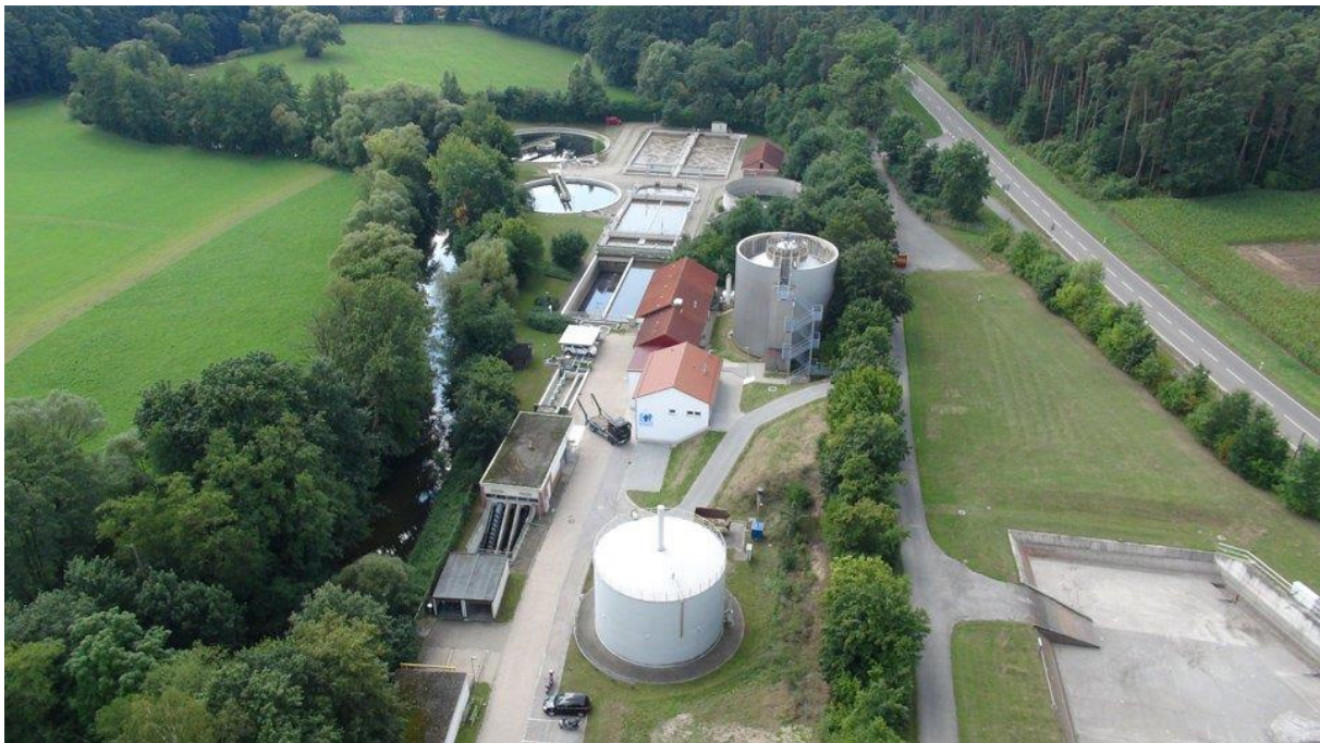
Ansicht auf die Kläranlage aus Osten
