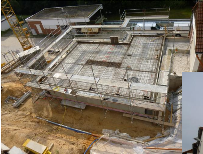
Bau neues Betriebsgebäude, Erdgeschoß
